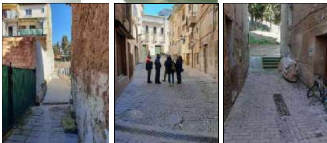
Ilustración 27. Vista de algunas de las alcantarillas principales por las que se inicia la inundación de Tudela por la crecida del Ebro. Se trata de 3 puntos diferentes del casco antiguo: calle Huerto del rey, zona de la calle Verjas/Arbollones, y zona de calle del Patio.
