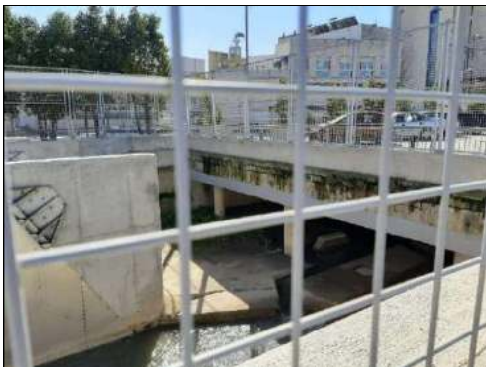
Ilustración 45. Imágenes tomadas en la confluencia del río Queiles con el Ebro. En este punto, recientemente se han instalado unas compuertas flotantes, que se cierran al aumentar el nivel del río Ebro, evitando así que sus aguas penetren en el tramo final encauzado del río Queiles, bajo las calles de Tudela. De esta forma se trata de evitar que se produzcan inundaciones a través del alcantarillado de la ciudad. En el punto más bajo de esta zona se encuentra una zona de aparcamiento que debe ser despejada en caso de crecida del Ebro.
