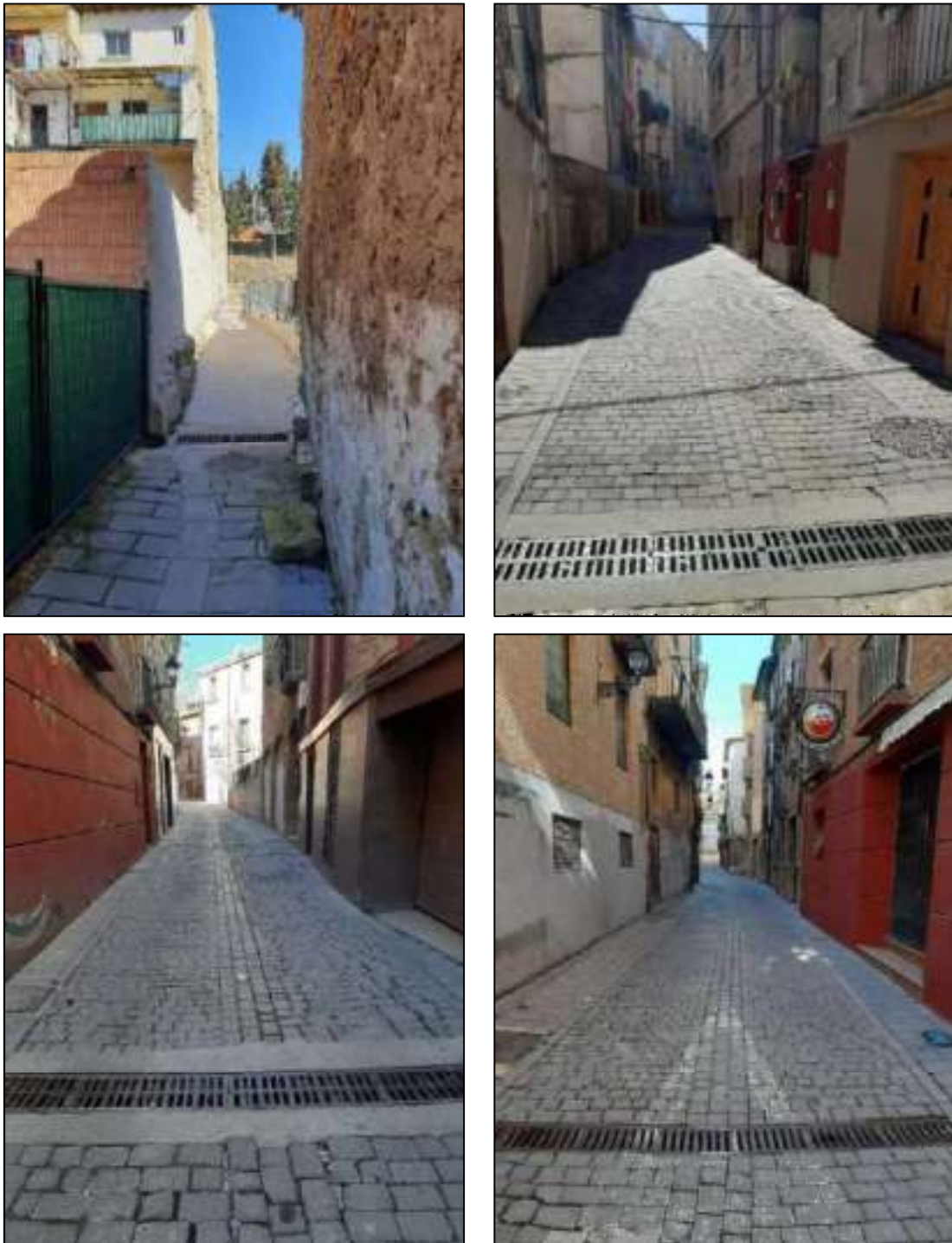
Ilustración 31. Imagen de cuatro de las alcantarillas en puntos bajos en Tudela.
