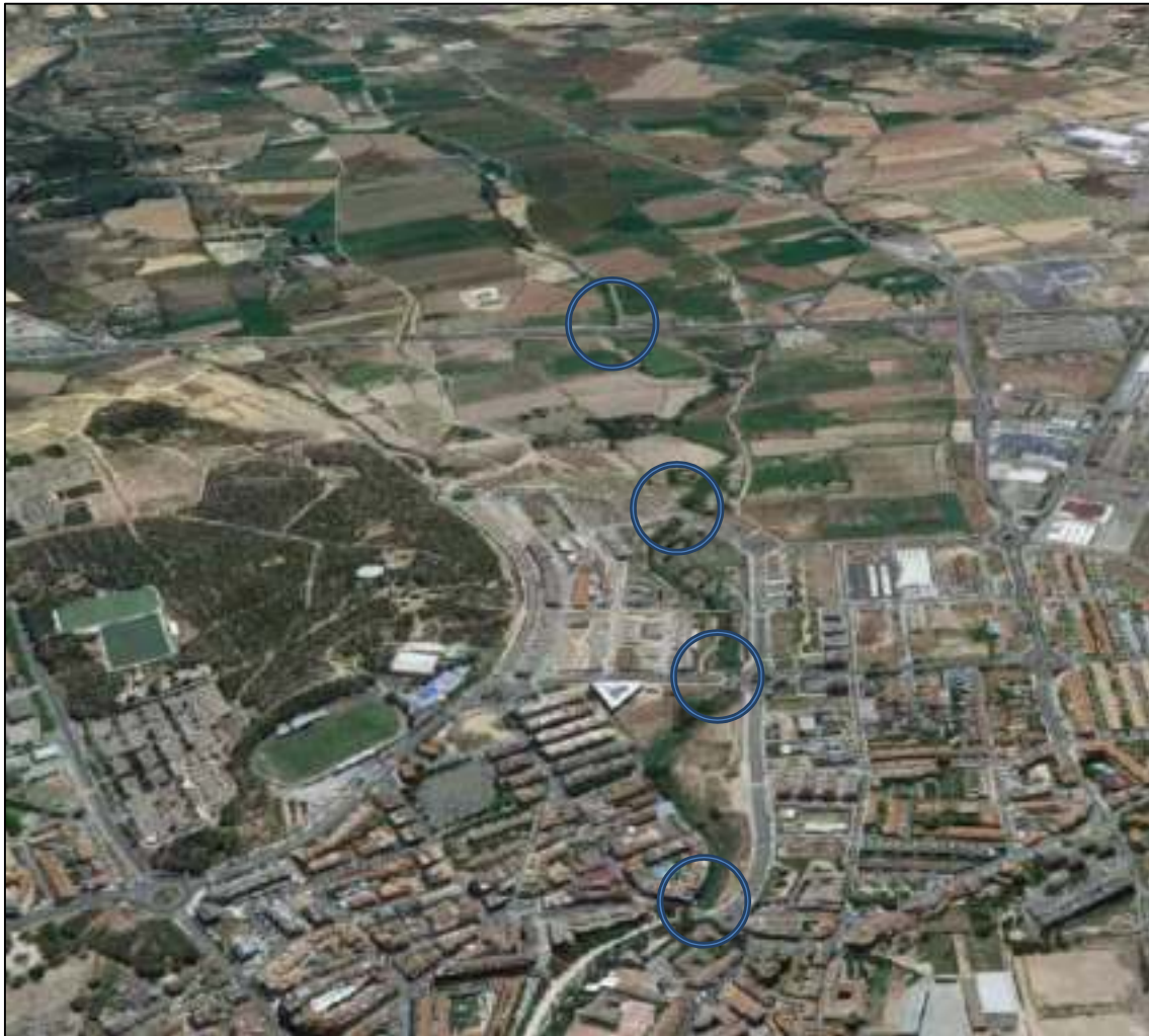
Ilustración 22. Vista aérea del trazado del río Queiles aproximándose primero al límite del término municipal de Tudela, para alcanzar posteriormente ya el propio casco urbano de la localidad. En esta imagen aérea obtenida de Google, se observa como el río debe cruzar bajo diversas infraestructuras, principalmente la autovía A-68, que van a influir sustancialmente sobre el desarrollo de la inundación.
