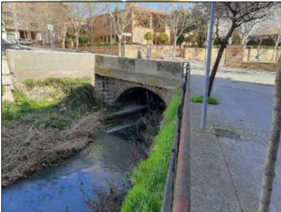
Ilustración 48. Vista de uno de los puntos de mayor importancia para analizar el riesgo de inundación en Tudela. Se trata del punto del soterramiento del río Queiles, en el inicio de la zona peatonal del Paseo del Queiles.
