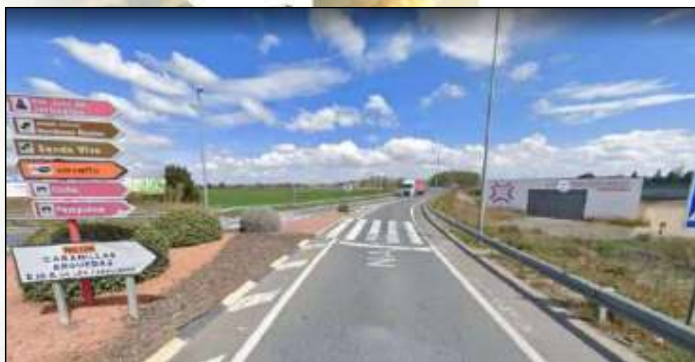
Ilustración 30. Imagen, obtenida de Google, del inicio de la carretera NA-134, en sentido norte, una vez el tráfico sale de la Autovía A-68. Esta imagen ilustra el punto identificado como [4] en la ilustración 28.
