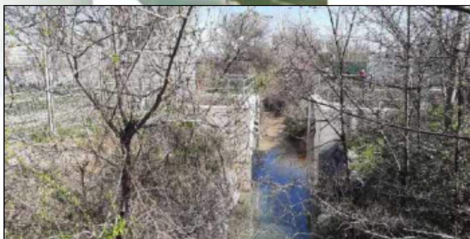
Ilustración 26. Fotografías de las compuertas recientemente instaladas en el tramo del Ebro en Tudela. La fotografía superior muestra el momento de la instalación de una de las dos compuertas flotantes que van a proteger la salida del cauce del Queiles, durante las avenidas del río Ebro. La segunda fotografía muestra la compuerta instalada en el punto de salida del barranco Mediavilla al Ebro, apenas unos 200 metros aguas arriba de la salida del Queiles.
